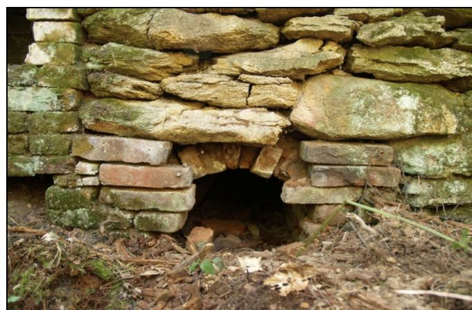
Рисунок 9 – Топка Полдневой печи (слева видны воздушные каналы для прогрева воздуха)
