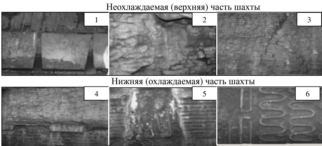
Рисунок 8 – Состояние рабочей поверхности шахты ДП №3 ОАО «ЗСМК» по данным спускаемого аппарата «Сканлайнер»: 1 – подвижные плиты колошника; 2 – зарождающая цинковая настыль в верхней части шахты; 3 – футеровка в неохлаждаемой зоне шахты, 4 – стык охлаждаемой и неохлаждаемой зон шахты; 5 – состояние холодильников в средней зоне шахты; 6 – змеевики, установленные совместно с кожухом взамен поврежденных с последующим торкретированием на ремонте печи
