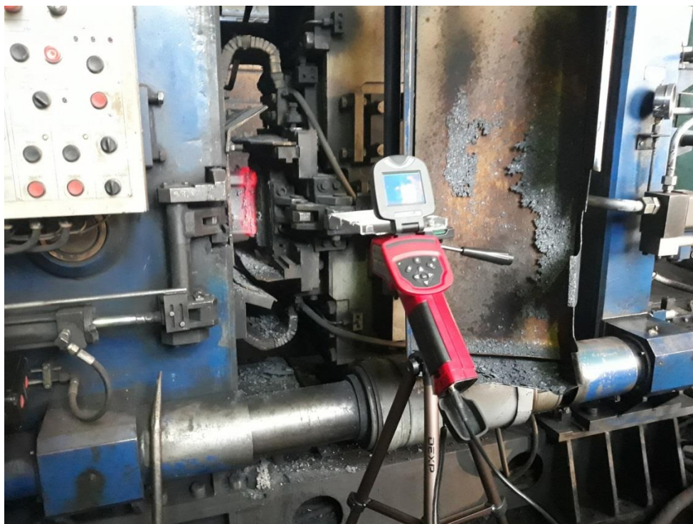
Рисунок 1. Оборудование для измерения температуры сварного соединения рельсов
